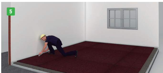
Colocar el piso y cortar el excedente de zócalo Neosound ® a filo.
