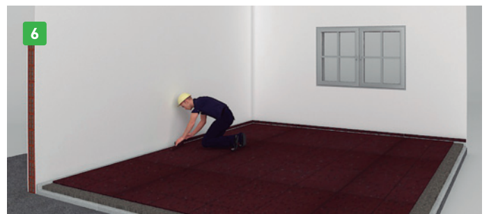
Colocar los zócalos adheridos a la pared interponiendo un material elástico en contacto con el piso.
