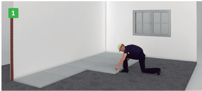
Preparación de la superficie: Quitar los restos de material y escombros. Colocar directamente sobre la losa las placas especialmente elasticadas Neosound ®. Adaptar las placas a la geometría del recinto cortándolas con ayuda de un cutter.
